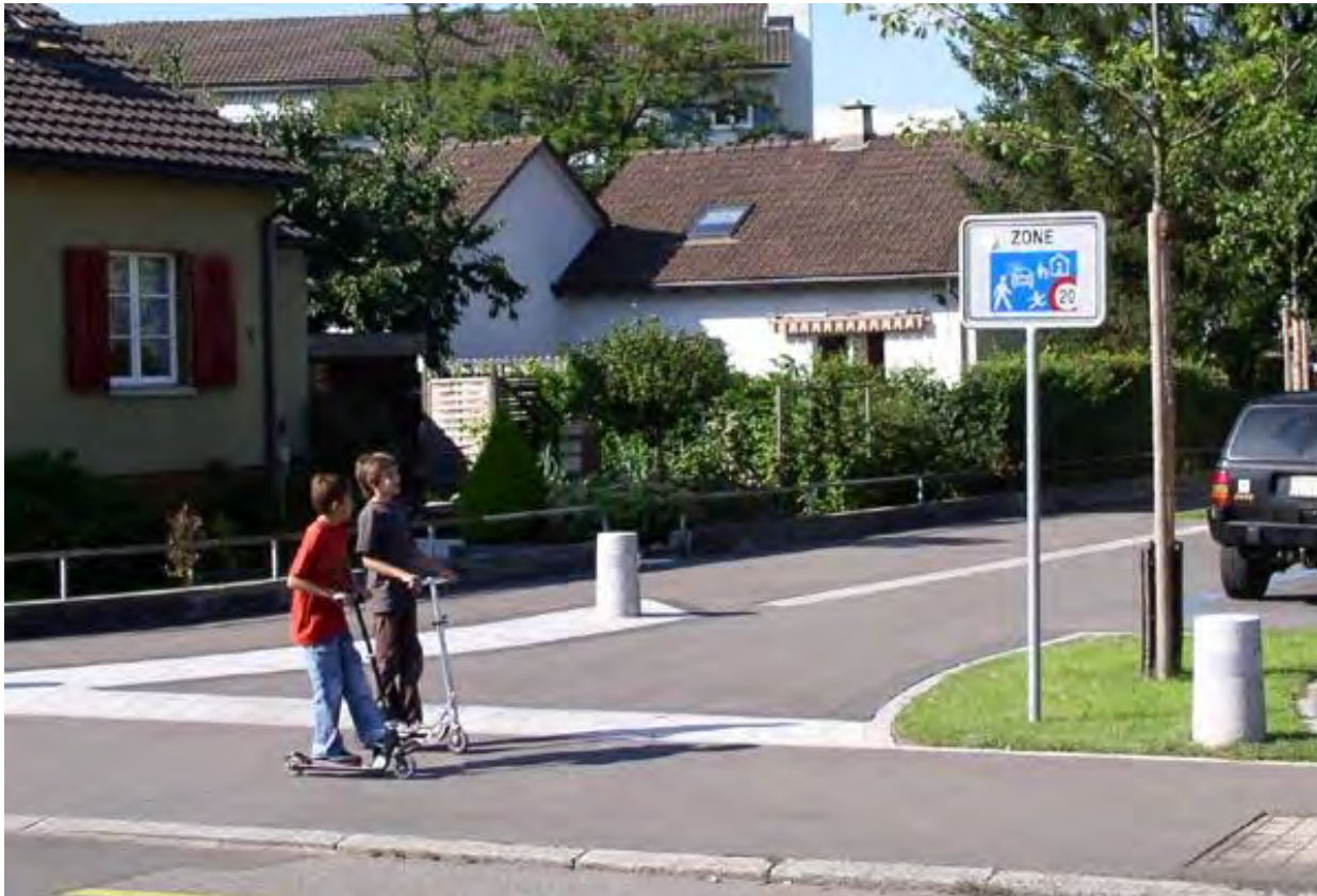
Abb. 12 Trottoirüberfahrt der Hofackerstrasse in Dietikon
