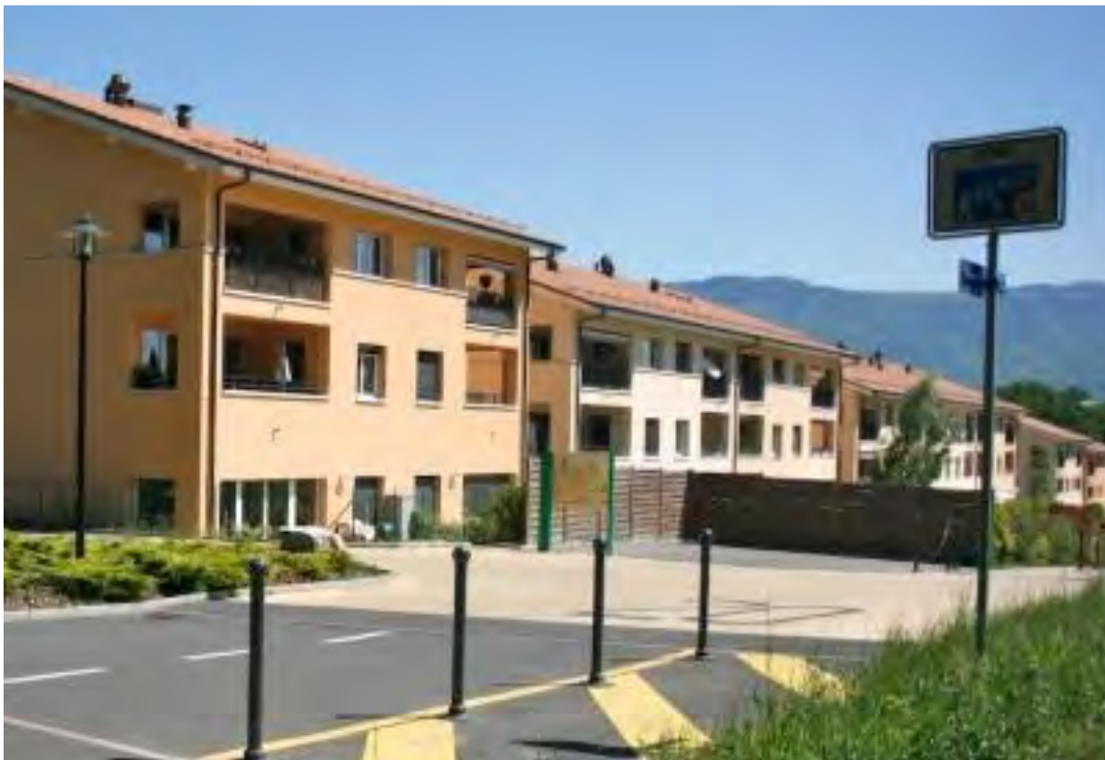
Abb. 15 Verwendung eines hellen Belags in Onex, Quartier de Belle-Cour
